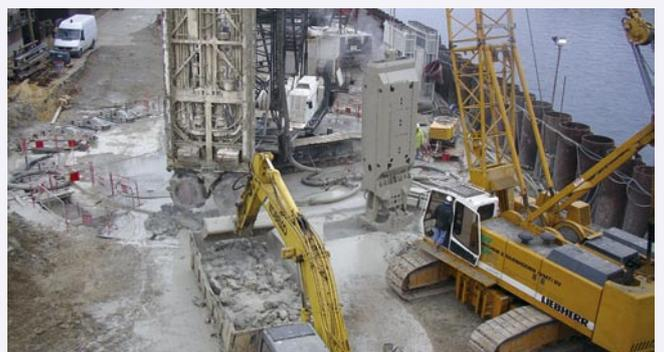
Le tout est aspiré en permanence par une pompe située à proximité des tambours jusqu'à une centrale de traitement où les déblais sont séparés du fluide de forage.
